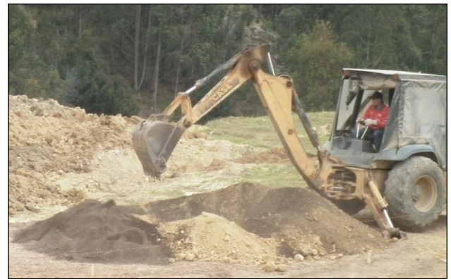
Foto No. 2 Mezcla estéril/compost (v/v) del tratamiento 3, proporción 2:1
